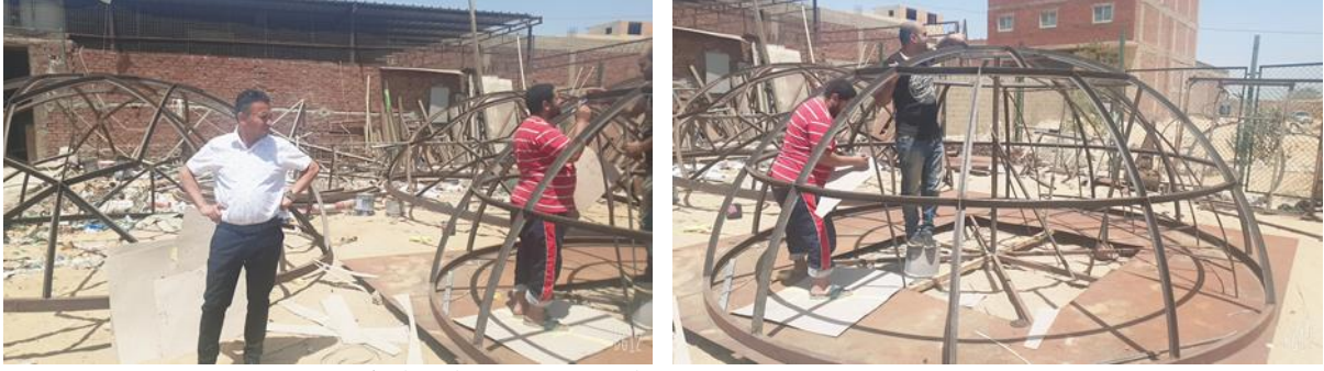
شكل ( ٢٦ ) يوضح القطاعات الانشائية للقطاعات الحديدية للقبة الأولى
