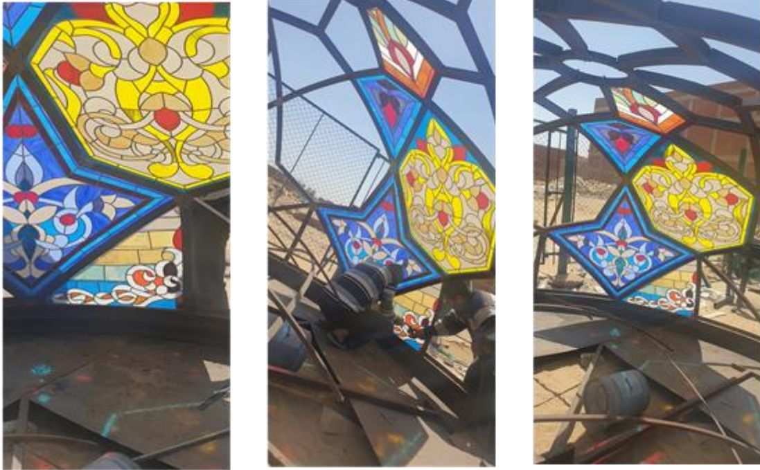
شكل ( ٣٨ ) يوضح عملية تجربة تركيب الزجاج المعشق لتحديد المقاسات الفعلية للتركيب
