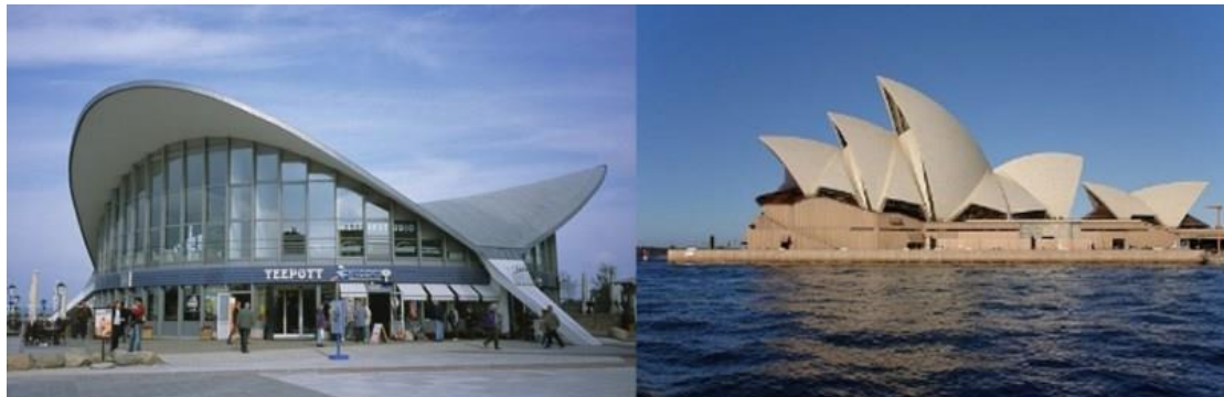
شكل ( ٨ ) يوضح النظم الإنشائية المستخدمة في تغطية البحور الكبيرة لبعض المباني المشهورة -نظام القشريات
