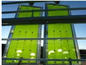
الشكل (٣٢) يوضح استخدام المياه المتاحة في الواح مبني (BIQ) في توليد الطاقة
