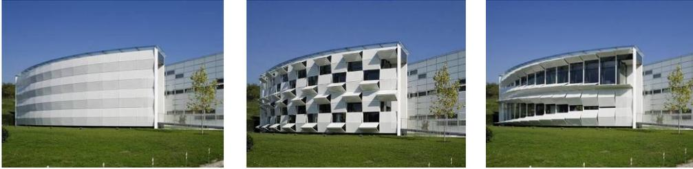
الشكل (٢١) يوضح تحول الشكل عند تعرضه للحرارة والعودة للشكل الطبيعي بعد فقدان الحرارة.
