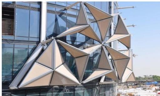
الشكل (١٥) يوضح تحول واجهة المبني وتفاعلها مع الشمس ديناميكيا من خلال الفتح والغلق لتوفير الطاقة الكهربائية، وتوضح شكل الدعامات الصلب الكابولي المثبتة بالكمرات لتثبيت وحدات المشربية.
