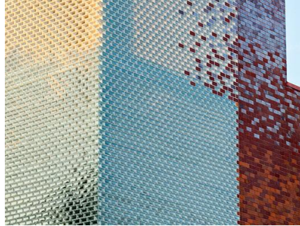
شكل (٢) الطلاء الزجاجي وتغيراته في الواجهات المعماريه الخزفية
