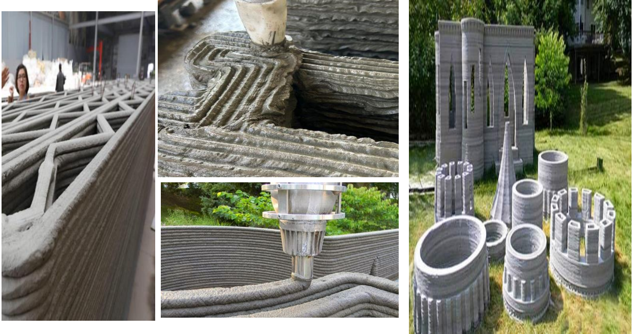
صوره رقم (7) يوضح الطباعة بالخرسانه.
